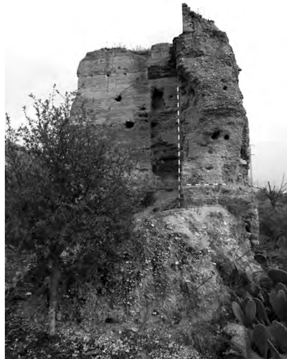
Lám. III: Torre de Marchena vista desde el Oeste.
