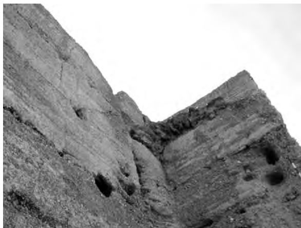
Lám. II: Detalle del ángulo interior de la torre.
