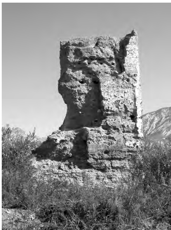
Lám. IV: Alzado S de la torre de Marchena.
