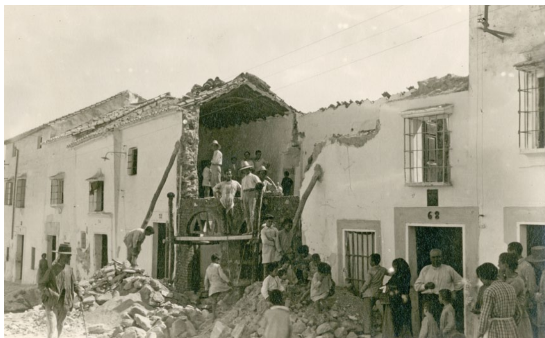
Fig. 10. Fotografía de los daños en Albolote (Granada) causados por el terremoto de 1956.
