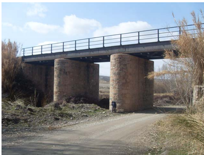
Figura 10: Puente definitivo para el paso del arroyo de Gor, aguas arriba del viaducto original
