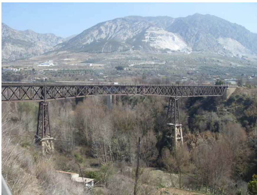
Figura 13: El puente de Dúrcal en la actualidad.
