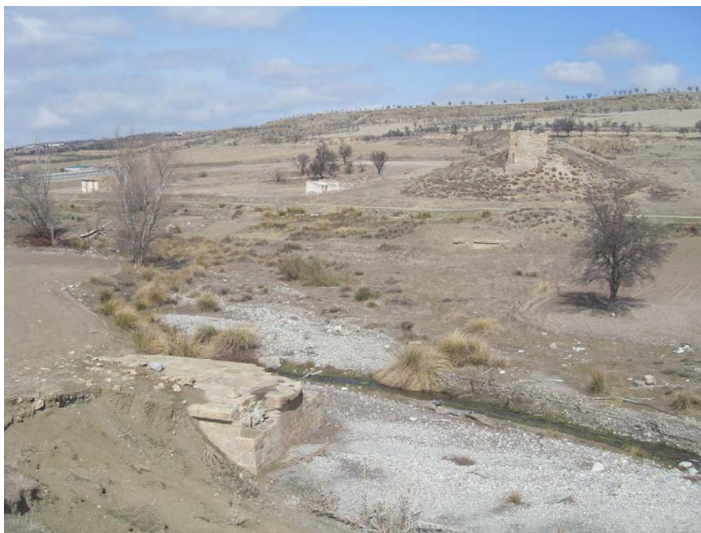
Figura 16: Basamentos de las pilas y estribo lado Baza. Se aprecia la magnitud del terraplén de acceso a pesar de la erosión sufrida en los últimos cien años.
