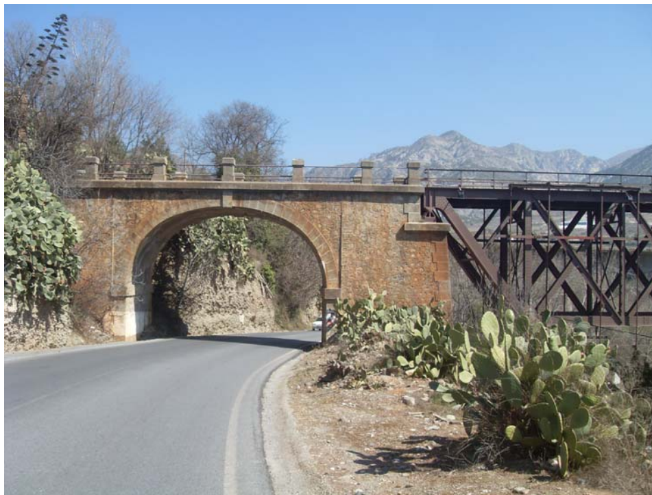
Figura 14: Estribo lado Granada en Dúrcal, resuelto con un arco de fábrica de mampostería.
