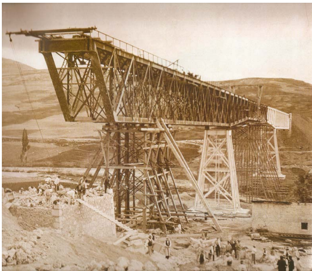
Figura 06: Trabajos de reconstrucción del estribo lado Baza, fotografía tomada por el ingeniero Gustavo Gillman en la primavera de 1906. Herederos de Gustavo Gillman.
